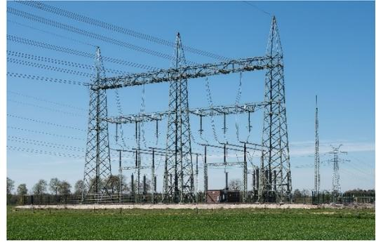
Figure 8. Teilverkabelung von Freileitungstrassen [6], Übergabebauwerk Freileitung-Kabel
