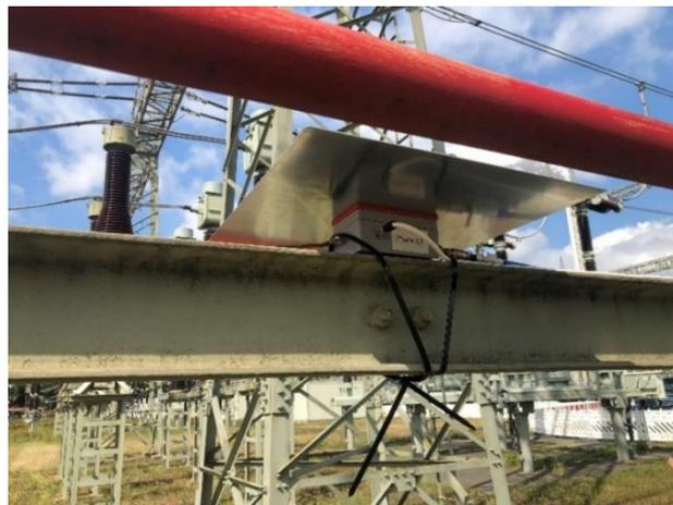
Abbildung 2. Messgerät installiert auf dem Träger eines Trennschalters [12].
