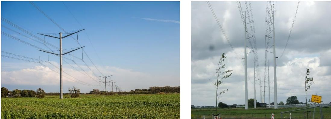
Abbildung 7: 380kV Doppelleitungen, links Mastbild „eagle“ in Dänemark (Bystrup Architekten), rechts Mastbild „Wintrack“ der Tennet in den Niederlanden (Autor)
