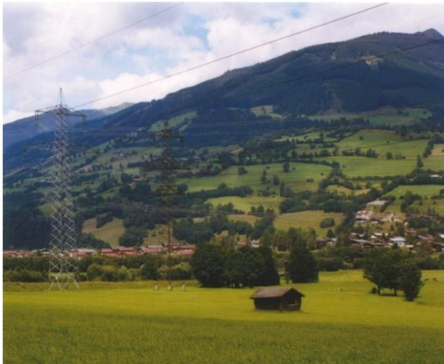
*Abbildung 9, 380kV „Tarnleitung“ in Tirol, links unbeschichteter verzinkter grauer Mast, rechts daneben dunkelgrün beschichteter Tarn-Mast - nur an den Fundamentsockeln zu erkennen [2]*
