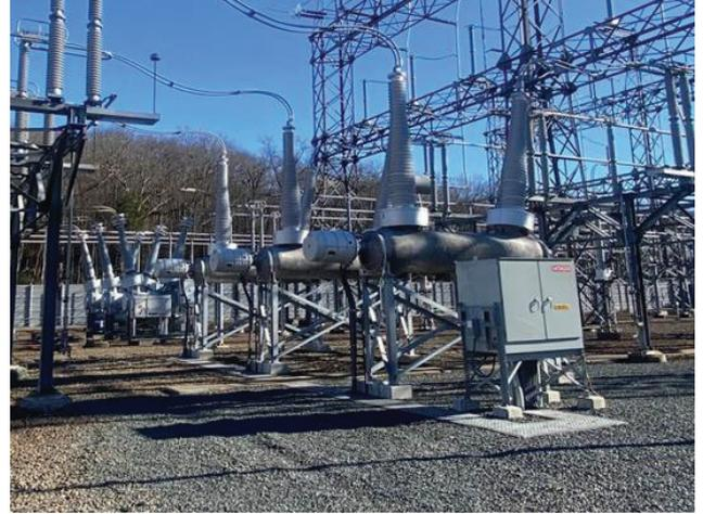
1-zu-1 Ersatz des Leistungsschalters mit minimalem Einfluss aufs Gesamtsystem
