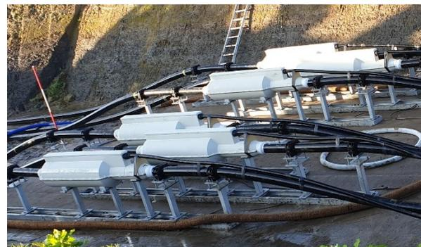
Figure 11. Montagefreundliche einteilige Verbindungsmuffe und Anordnung in der Muffengrube, Bild: Südkabel
