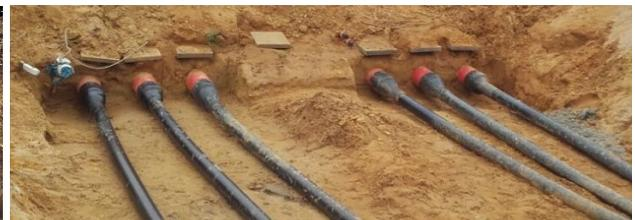
Figure 9. Typische 400 kV Kabelprojekte in Deutschland, 400kV/2500mm<sup>2</sup> Kabel in Rohrverlegung
