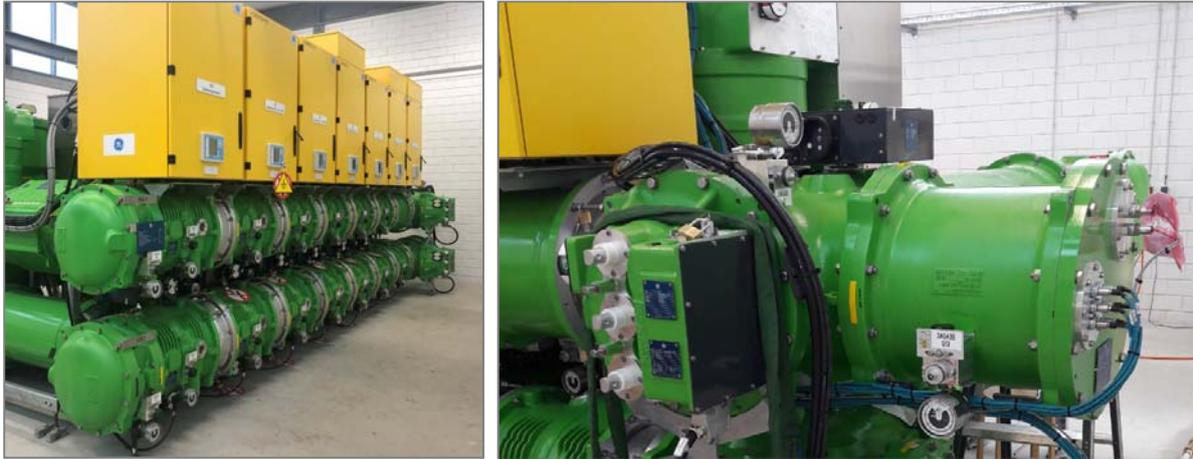
Bild 11: Unterwerk Middelharnis als 7-feldrige Anlage mit Low-Power Kombiwandlern (links) und Low Power Spannungswandlern am Ender der Sammelschine ermöglichen die Strom- und Spannungsmessung, basierend auf IEC 61850-9-2
