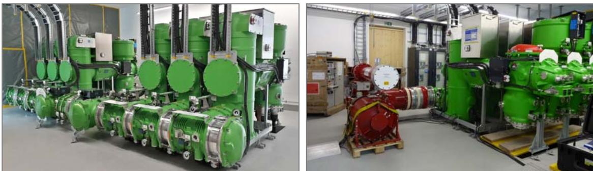
Bild 10: Unterwerk Zernez als 6-feldrige g<sup>3</sup> Anlage (links) wurde geprüft mit einem mit g<sup>3</sup> isoliertem Prüf-Transformator (rechts)
