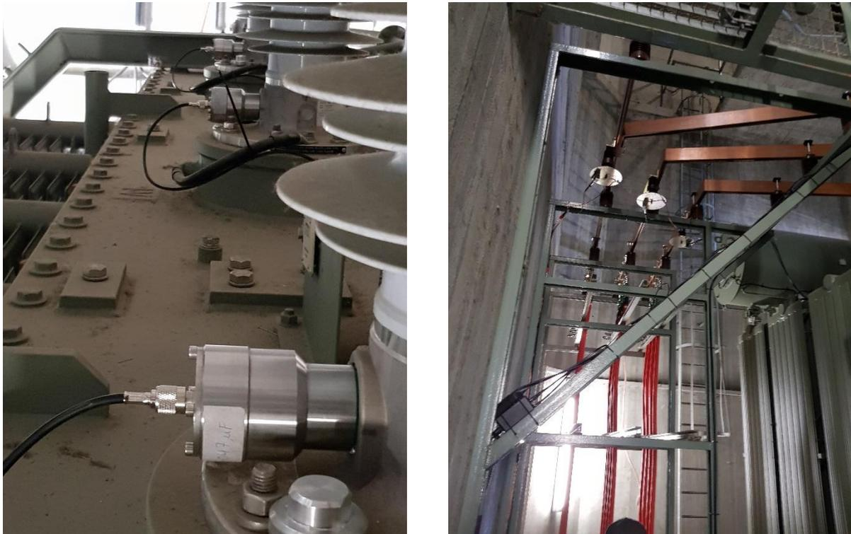
*Bild 3. Fotos der Installation am Transformator, links: kapazitive Sensoren an den Durchführungen, rechts: Mittelspannungssensoren von Kupferschiene abgehängt*
