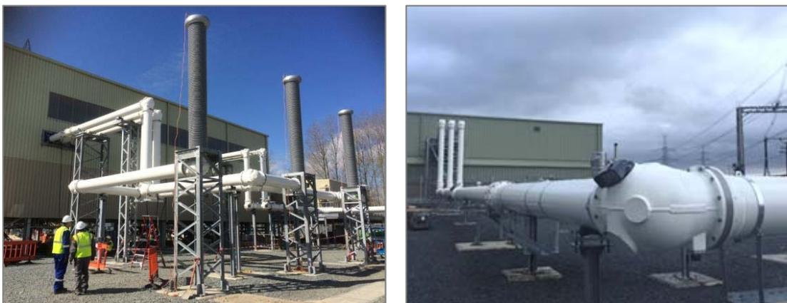
Bild 12: Freiluftausleitungen, 420kV in g<sup>3</sup>, links «Sellindge» NG, rechts «Kilmarnock» SPEN
