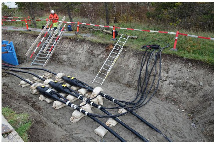
Abbildung 6: Installation der Kabelmuffen mit Sensorik
