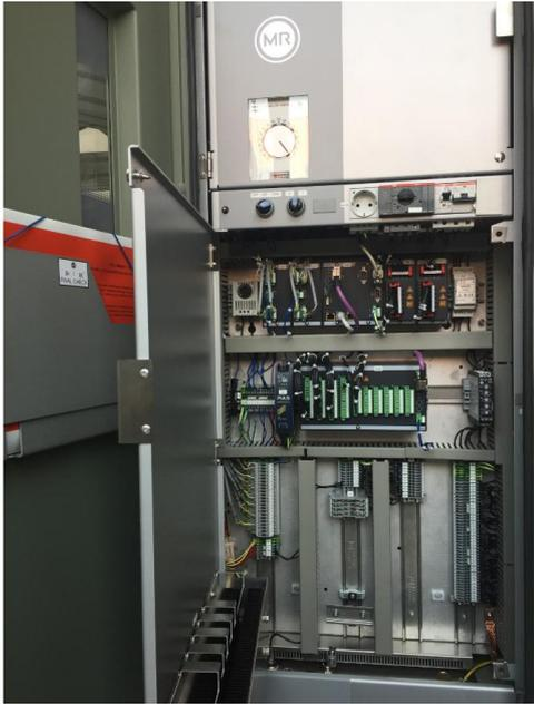
Bild 6: Blick in den neuen Motorantrieb TD ISM an einen Transformator ausgerüstet mit dem integrierten Steuerungs- und Monitoringsystem
