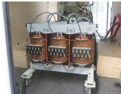
*Bild 10: Anpasstransformator*
