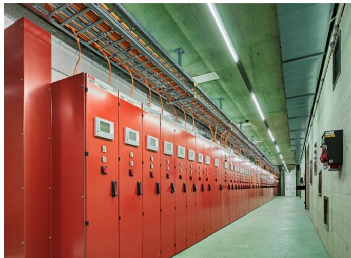
Abb. 15 Die Schaltanlage ist aus 50 Feldern vom Typ ZX2 aufgebaut
