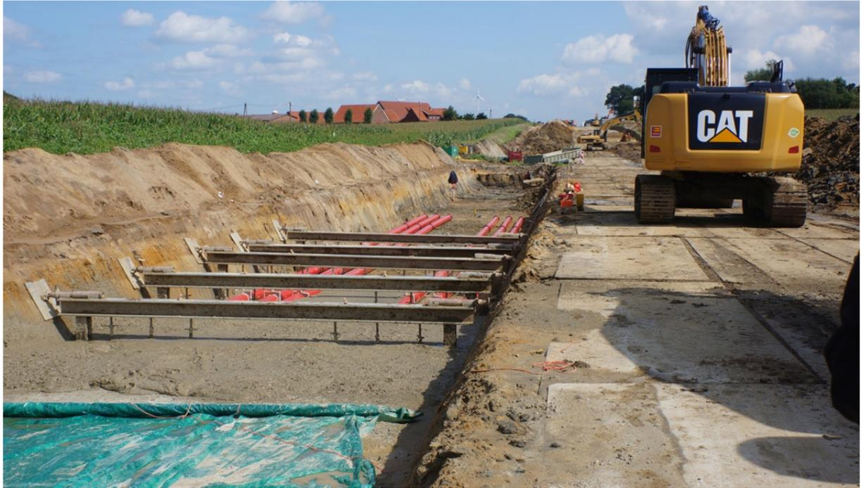
*Abbildung 4. Einbettung der Schutzrohre in Flüssigboden*
