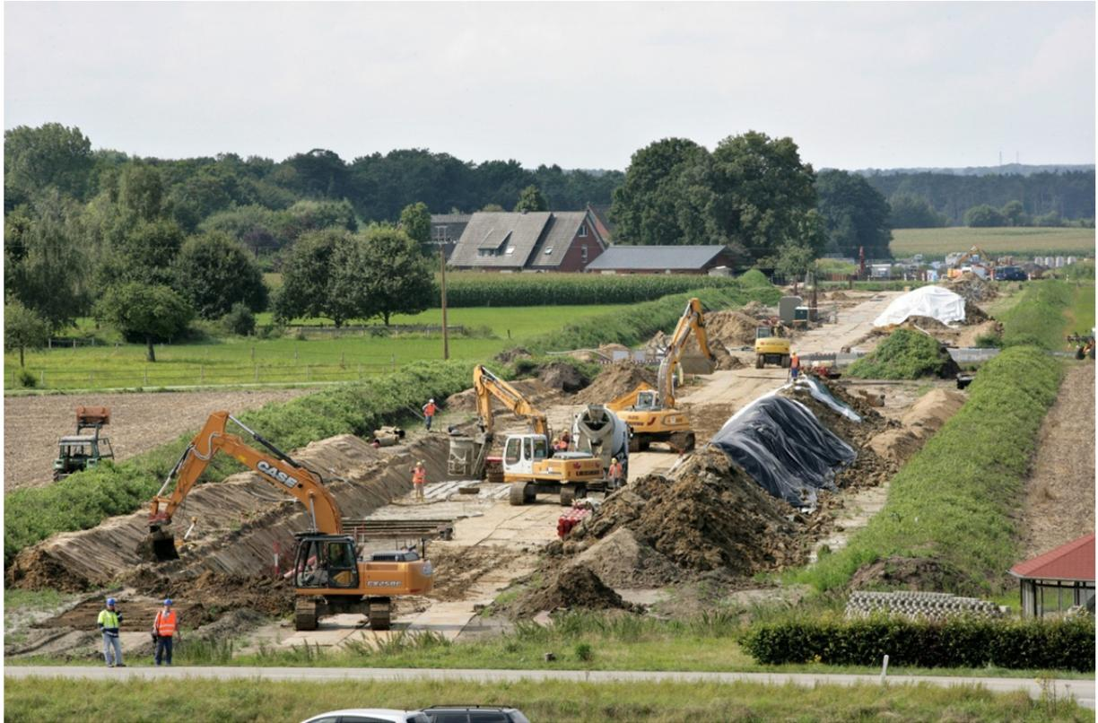
*Abbildung 3. Kabelschutzrohrverlegung*
