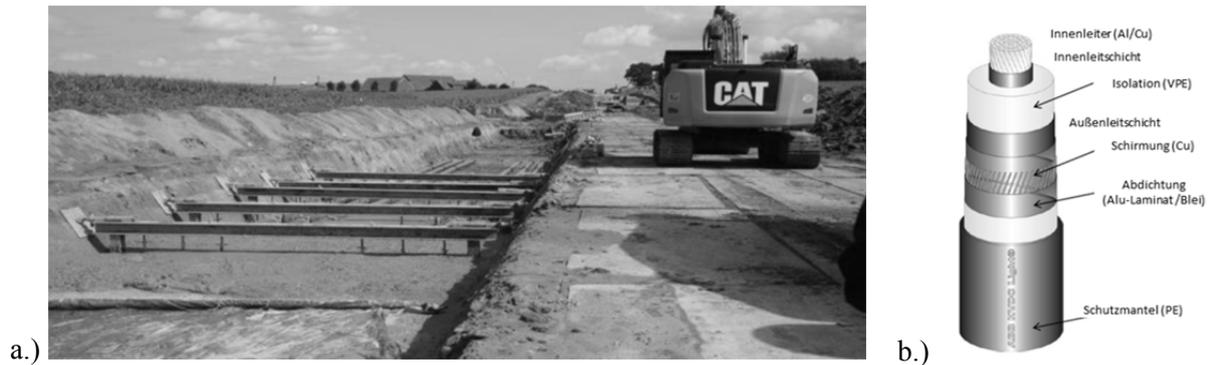
Abbildung 11. Erdkabelsysteme für Höchstspannungsnetze
