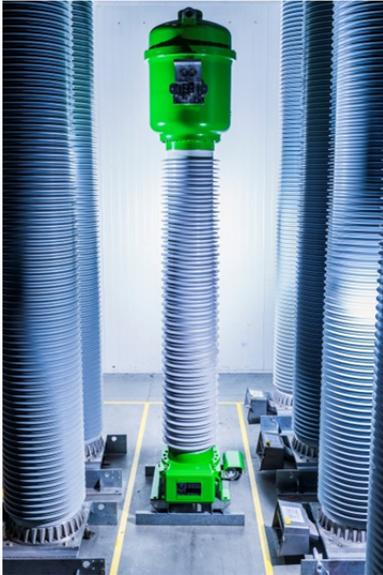
Bild 8:  $g^3$ -Stromwandler der 245 kV-Ebene
