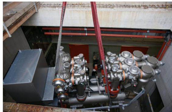
Abb. 19 Ein HS-GIS-Feld wird per Transportschacht in das Unterwerk gehievt
