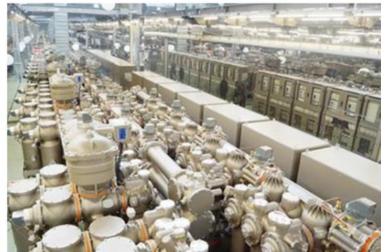
Abb. 11 Die Schaltanlage ist aus 8 Feldern vom Typ ELK-14 C aufgebaut
