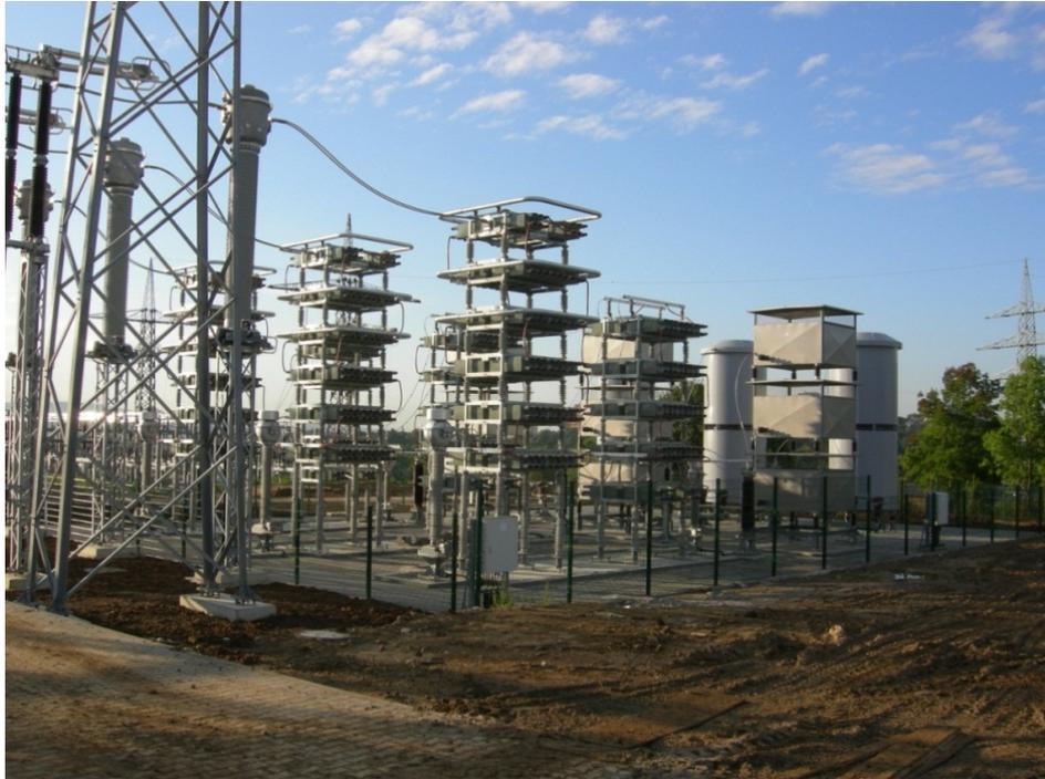
Abb. 4. Kondensatorbank im Umspannwerk Mühlhausen
