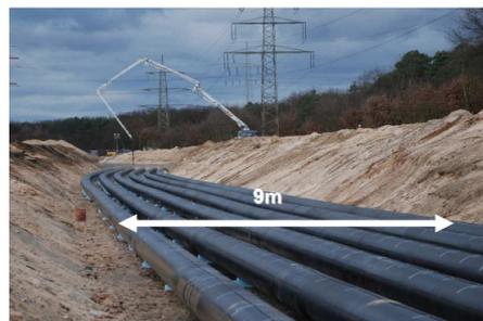
Bild 5: Verfüllen der GIL-Rohre mit Flüssigboden
