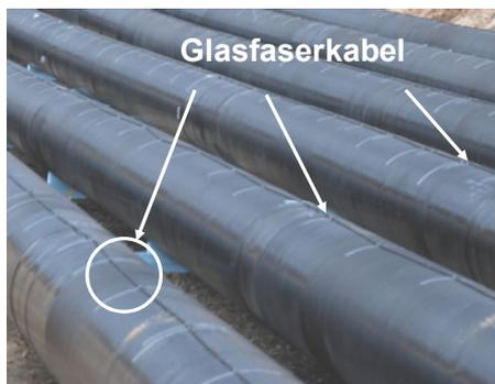
Bild 12: Glasfaserkabel zur Temperaturüberwachung
