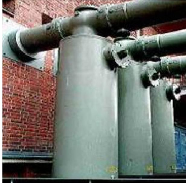
Abbildung 7 Grafische Darstellung und Anwendungsbeispiel eines „GIS-Ableiters“ (Werkbilder SIEMENS)
