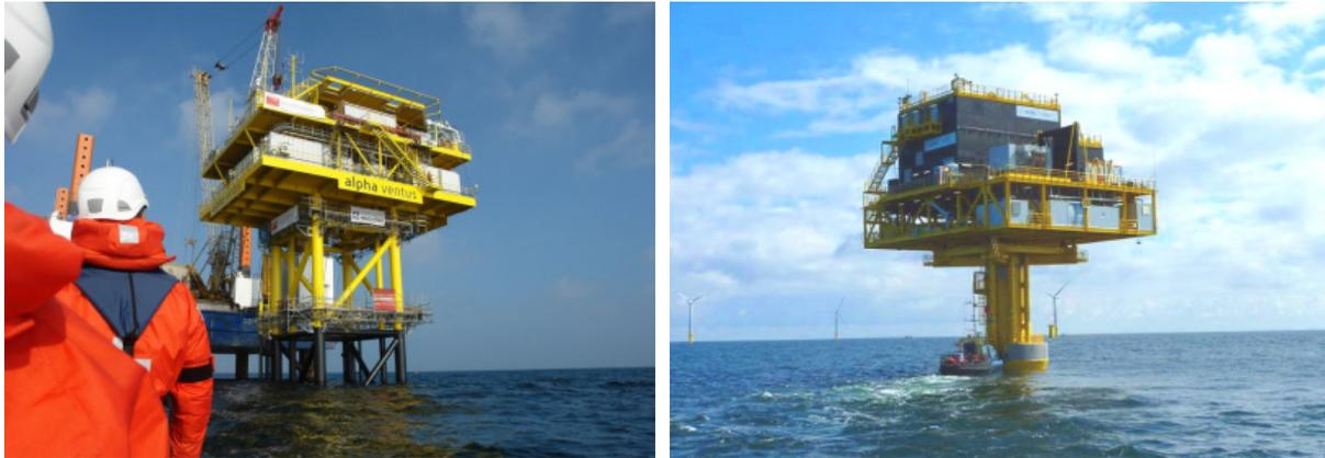
*Bild 1: Links: Alpha Ventus, die erste AC Offshore-Plattform in der deutschen Nordsee, ausgestattet mit einem 75-MVA-Hermetiktransformator, seit 2009 in Betrieb, rechts: Baltic 1 AC Offshore-Plattform in der deutschen Ostsee; Inbetriebnahme Mai 2011*
