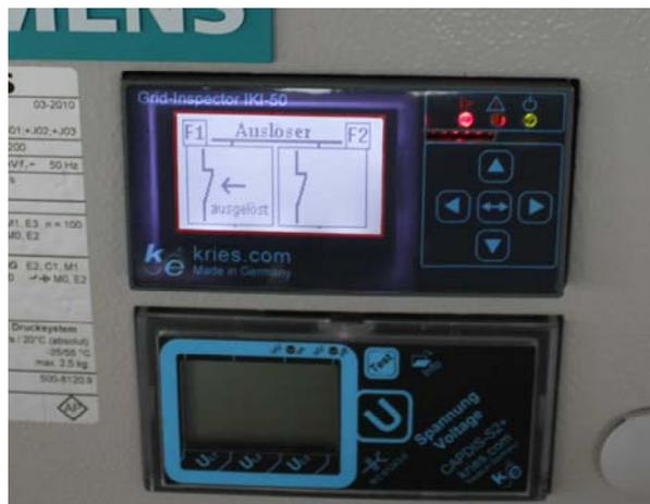
Bild 5.2 Feldsteuer- u. Messgerät IKI-50 zusammen mit Spannungsprüfsystem IKI-50 eingebaut in einem Standard-Schaltfeld einer Lastschaltanlage
