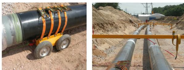
Bild 4: Vorrichtungen zum Ziehen und zum Fixieren der GIL-Rohre
