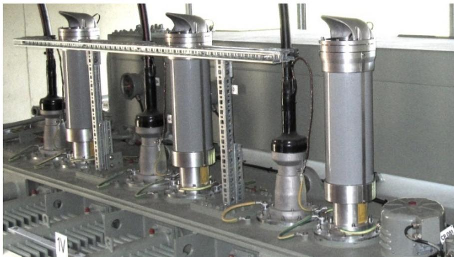
Abbildung 13 Steckbare feststoffisolierte Überspannungsableiter für  $U_m = 72,5$  kV auf Transformator
