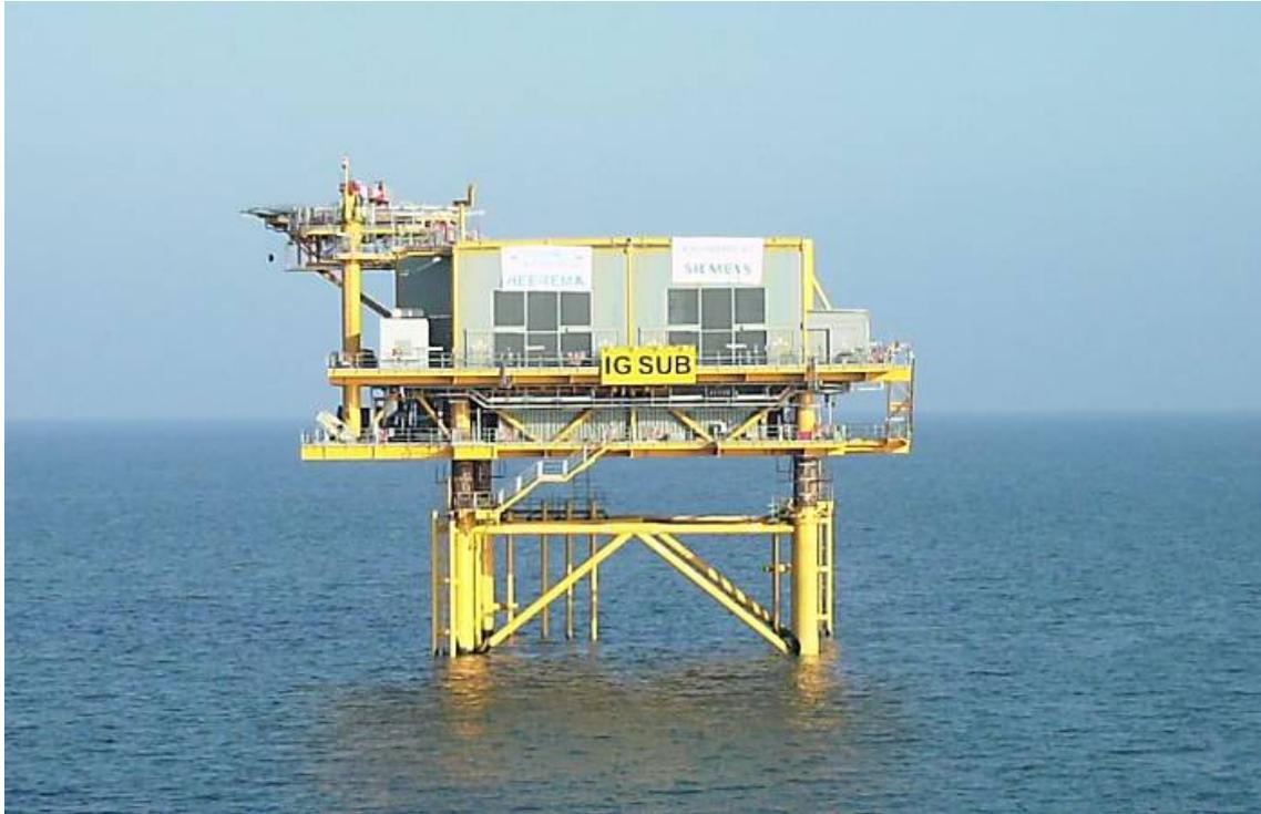
*Bild 2. Offshore-Plattform Greater Gabbard betriebsbereit (3x180MVA)*
