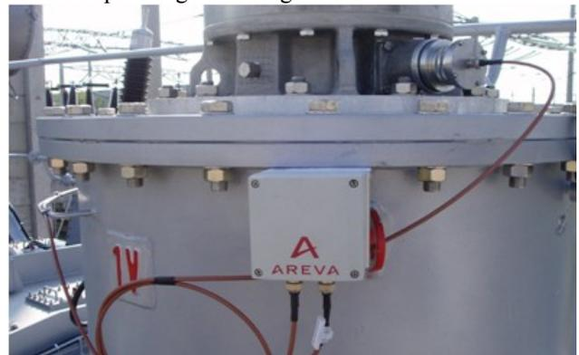
**Bild 5** Spannungssensor, installiert am Messanschluss der Durchführung
