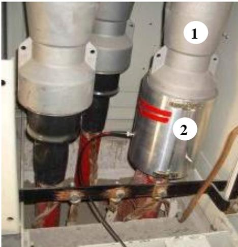
Abbildung 6.1 Vor-Ort-Messaufbau: 1. Stecker, 2. Schirmgehäuse mit Sensoren
