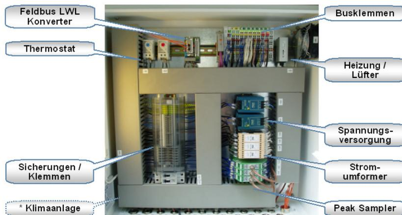
Abbildung 3: Innenansicht eines Monitoring-Moduls mit Komponenten zur Messdatenerfassung und -verarbeitung (\*optional)
