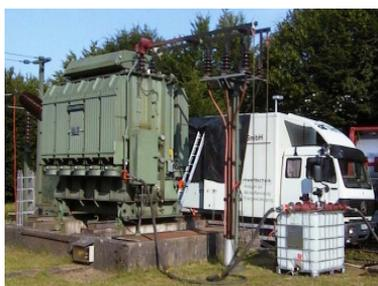
Abbildung 8: LFH-Trocknung mit Ölzirkulation
