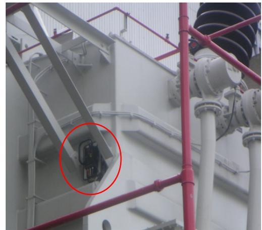
**Bild 2:** Akustische TE-Messung mit ABB-Sensor
