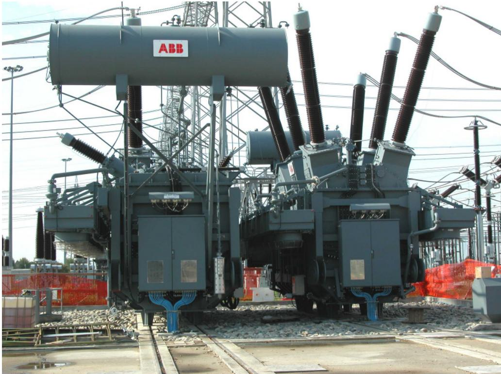
Abbildung 6: 1630 MVA, 400 kV, 18° Querregeltransformator für TERNA. Verluste  $\sim 2600$  kW, Masse  $\sim 820000$  kg, Abmessungen ca. 13.2 x 15.3 x 10.2 m
