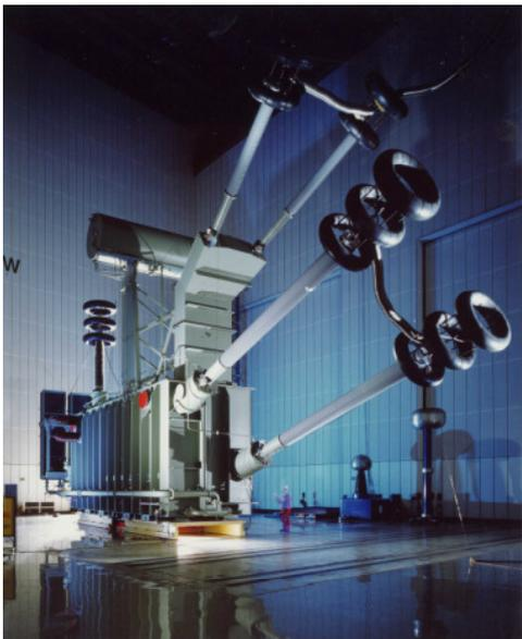
Bild 6: 345 MVA Yd/Yy Einphasentransformator für China
