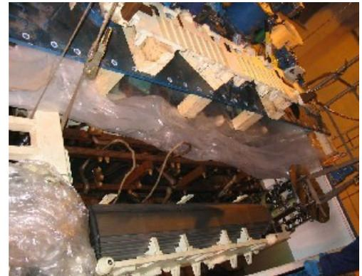
**Bild 14:** OSR Kategorie B4: Austausch eines Wicklungsblocks bei einem 35MVA Ofentransformator
