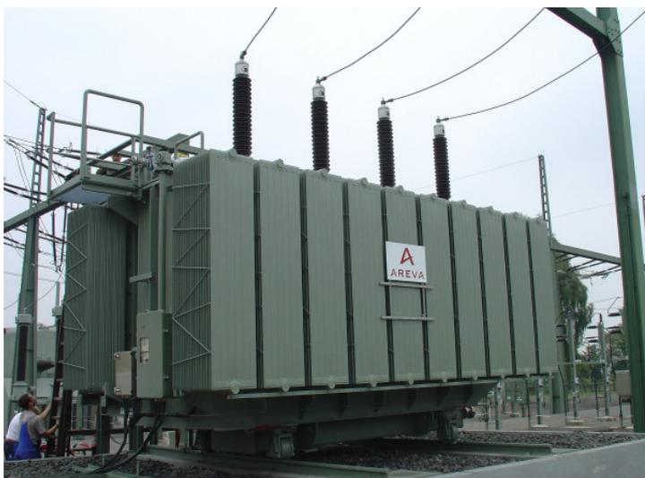
Abbildung 4: 40 MVA, 110 kV Hermetiktransformator, Kunde: E.ON Westfalen Weser AG
