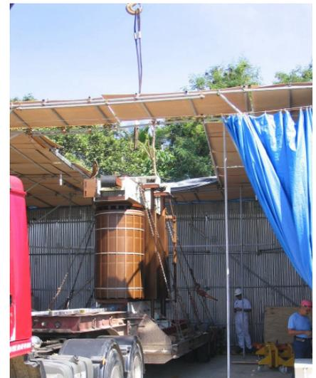
**Bild 15:** OSR Kategorie C4: Erneuerung eines Wicklungsblocks bei einer 230 kV / 50MVAr Drossel
