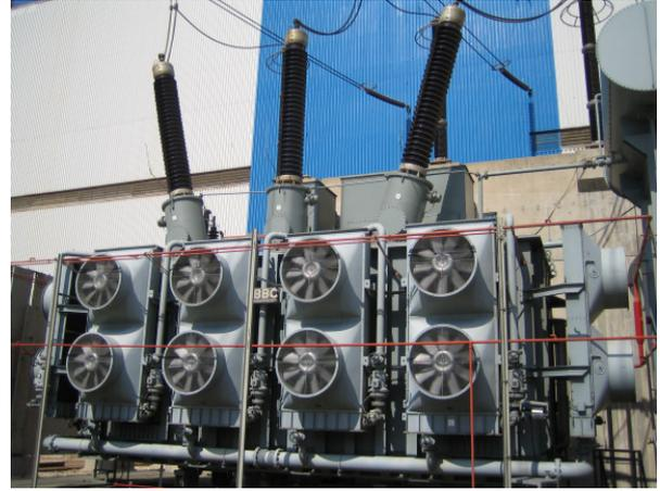
**Bild 13:** OSR Kategorie A2: Austausch aller Wicklungen an einem 420 kV / 520 MVA Maschinen-
