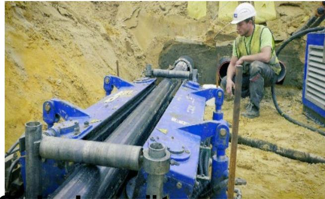
**Schubgeräte zur Reduzierung der Zugkräfte**
