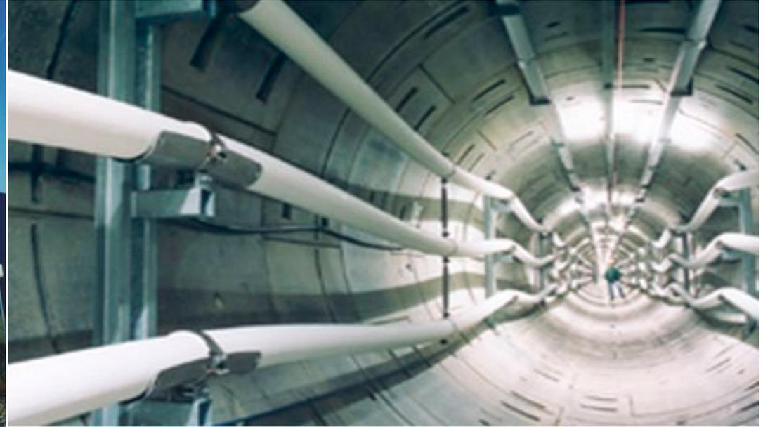
**Erste Anwendungen der 400kV VPE-Kabeltechnik in Deutschland**
