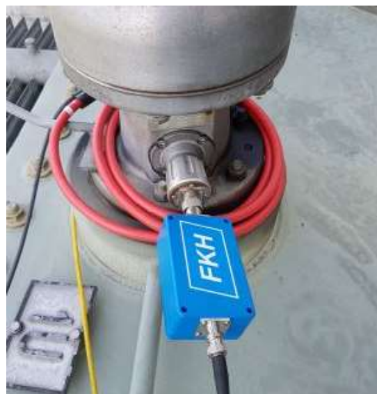
Bild 8 Installation eines kapazitiven Adapters an der Durchführung (zusätzlich Rogowski-Stromzangen installiert)
