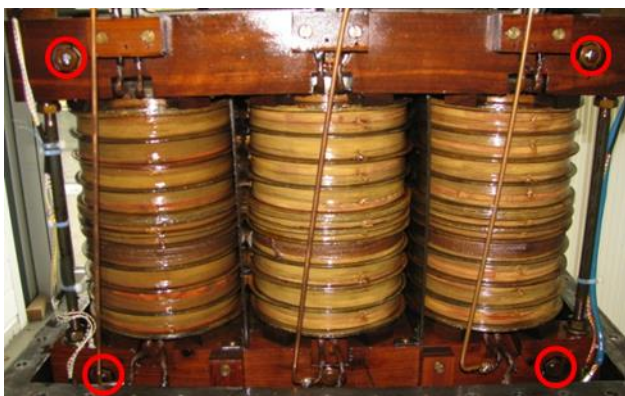
Bild 3 Seitenansicht des Aktivteils mit Holzrahmen zur Fixierung des Kerns und 4 Querbolzen mit Muttern zum Einstellen der Einspannkraften (rote Markierungen).
