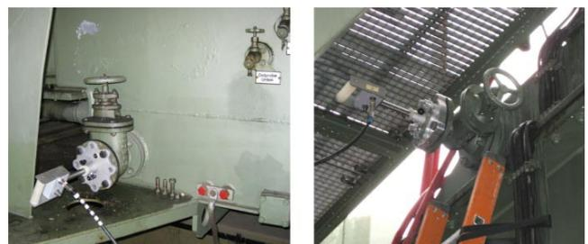
**Bild 16:** Installierte UHF Sensoren
