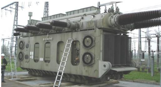
**Bild 5:** 210 MVA Netzkuppeltransformator
