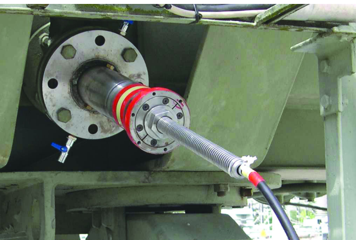
Bild 4. Flansch mit Spindel zum Einfahren des UHF-Sensors bei geöffnetem DN80-Flachkeilschieber (an der unteren Kesselöffnung zur Ölbefüllung)
