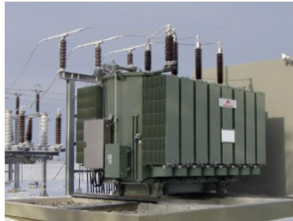
**Bild 3: 80 MVA, 110 kV-Leistungstransformator in Hermetikbauweise**
