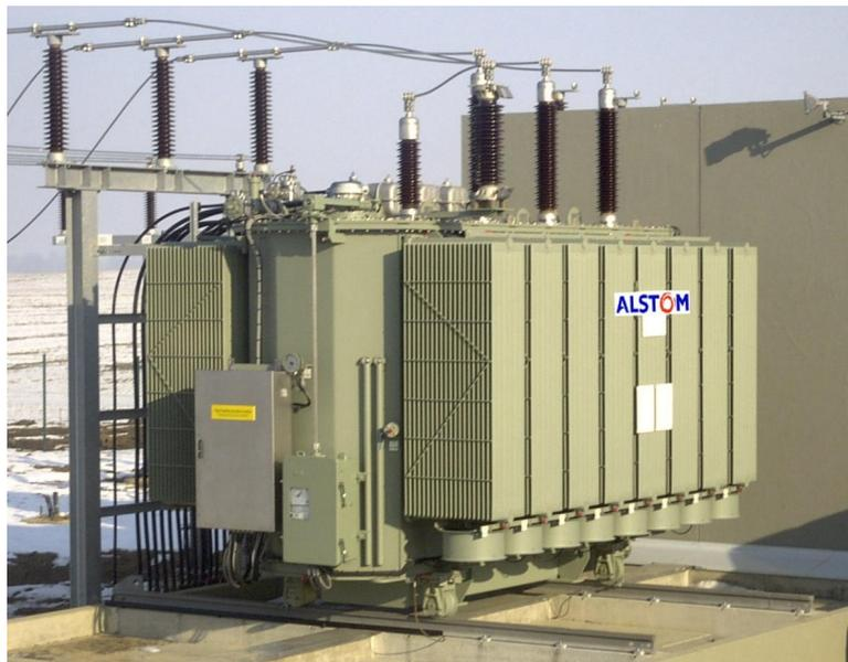
Bild 4: Hermetisch geschlossener Leistungstransformator 80 MVA / 110 kV
