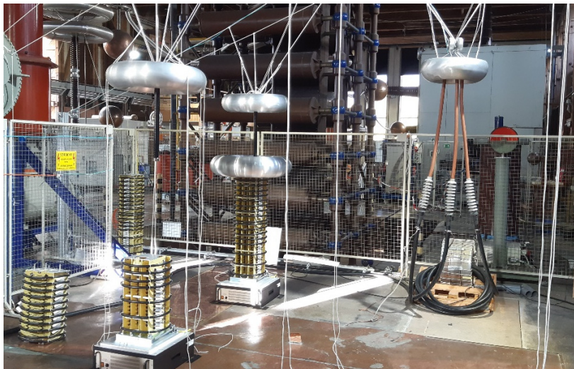
Fig. 2: Hochspannungsversorgung im Aufbau High-Voltage supply under construction
