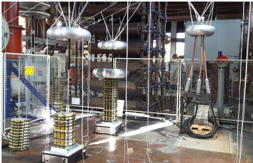
Fig. 2: Hochspannungsversorgung im Aufbau High-Voltage supply under construction
