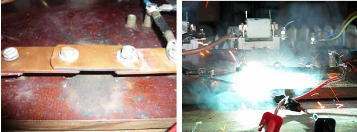
Fig. 2: Nachbildung eines seriellen Lichtbogens durch sich lösende Verschraubungen der Sammelschienen. Der Kontakt zwischen den Sammelschienen wurde oxidiert und besitzt so einen erhöhten Widerstand, was zu einem Lichtbogen führt.
